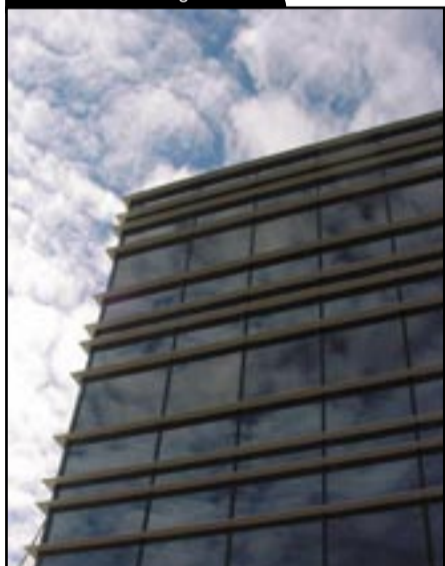
Detalle do edificio Agora.
