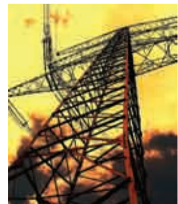
Frear o consumo de enerxías non renovables contribúe a conservar o medio ambiente.
